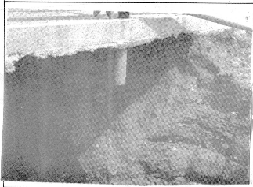
PUENTE DE LA CARRETERA BARQUISIMETO-DUACA
