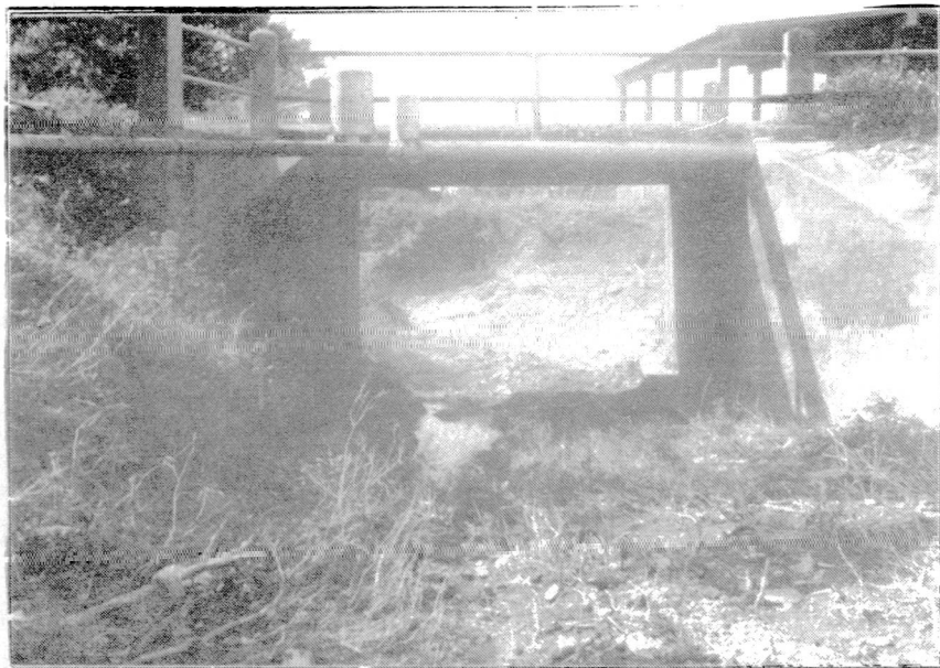
RIO TACARIGUA Altura alcanzada en el Puente hacia San Sebastián
