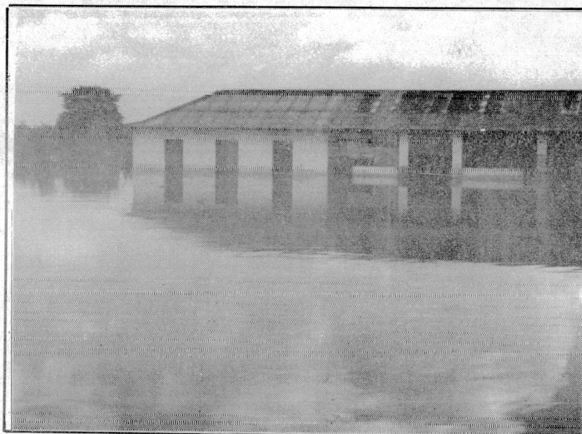
8.- Nivel alcanzado por las aguas en las haciendas cercanas.-
