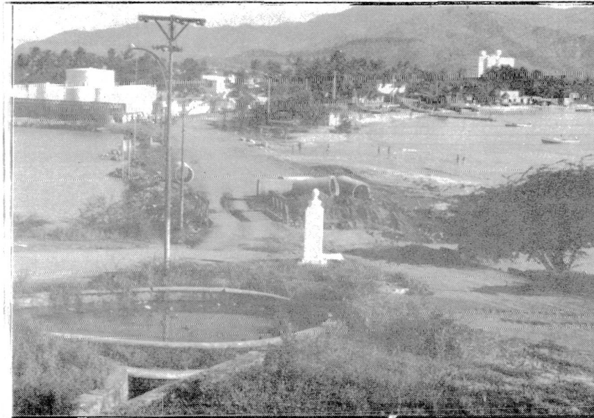
Represamiento de las Aguas Vía El Fortín
