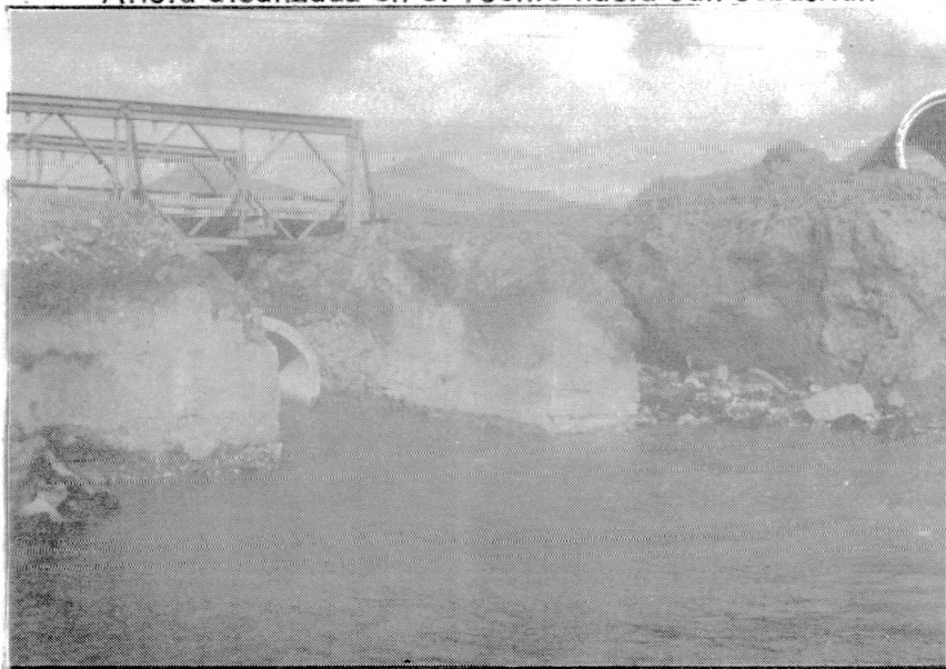
PTE. LOS FERMINES Vía El Fortín
