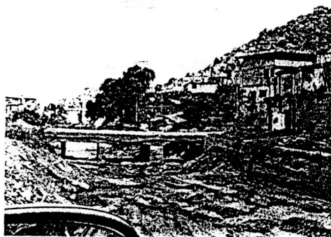
Foto 8a. Vista del Puente de la Quebrada Curucutí. Nótese la reducción de la sección hidráulica por efecto de las pilas del puente.
