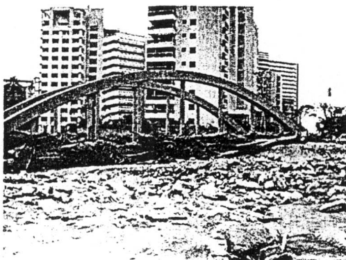
Fotos 54 y 55. Obstrucción del puente del Río Camurí Grande y daños en casas sobre la margen derecha.
