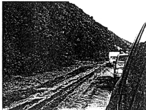
Fotos 45 y 46. Excavación de material de laderas y depósitos de materiales finos que obstruyen la vía carretera Tanaguarena-Naiguatá.
