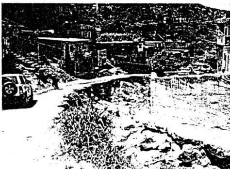
Fotos 62 y 63. Erosión lateral y del lecho en vía de acceso hacia las presas (izquierda). Puente bajo con sección parcialmente colmatada de sedimentos (derecha).
