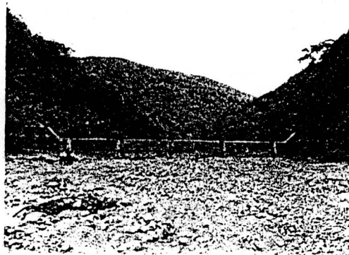
Fotos 5 y 6. Presa N° 3 del tipo abierta de concreto ciclópeo en la Qda. Curucutí. Vista desde aguas abajo (izq.) y desde aguas arriba (derecha).
