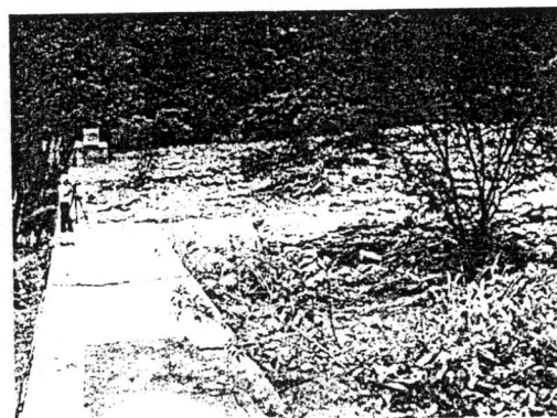
Fotos 3 y 4. Vista frontal de la Presa N° 2 (izquierda) y vaso totalmente sedimentado (derecha) en la Quebrada Curucutí.
