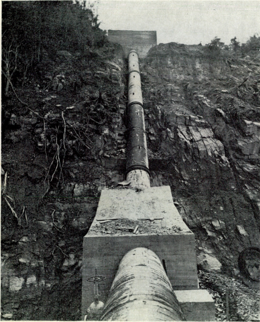
Tubería de Tumare, entre las Estaciones 3 y 4.
