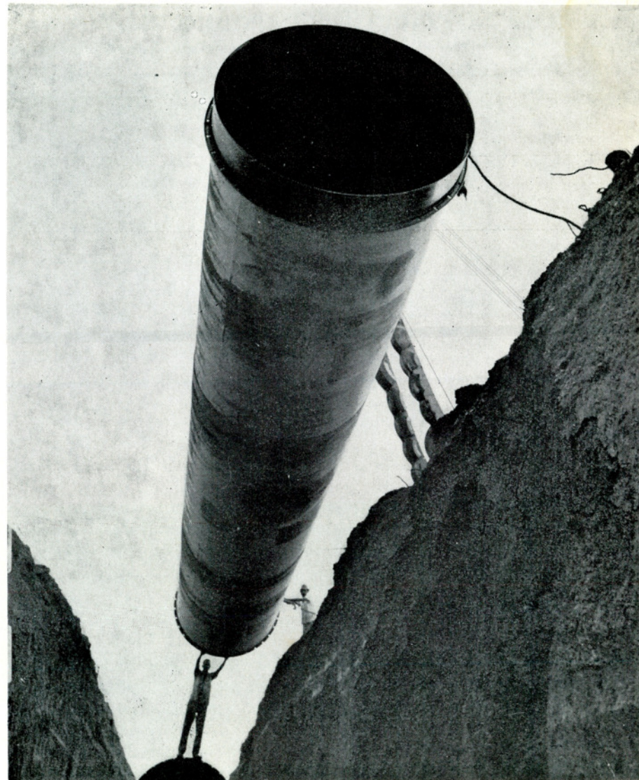
Un enorme trozo de tubería pasa a ocupar su lugar en el largo tendido que trae el agua a Caracas.
