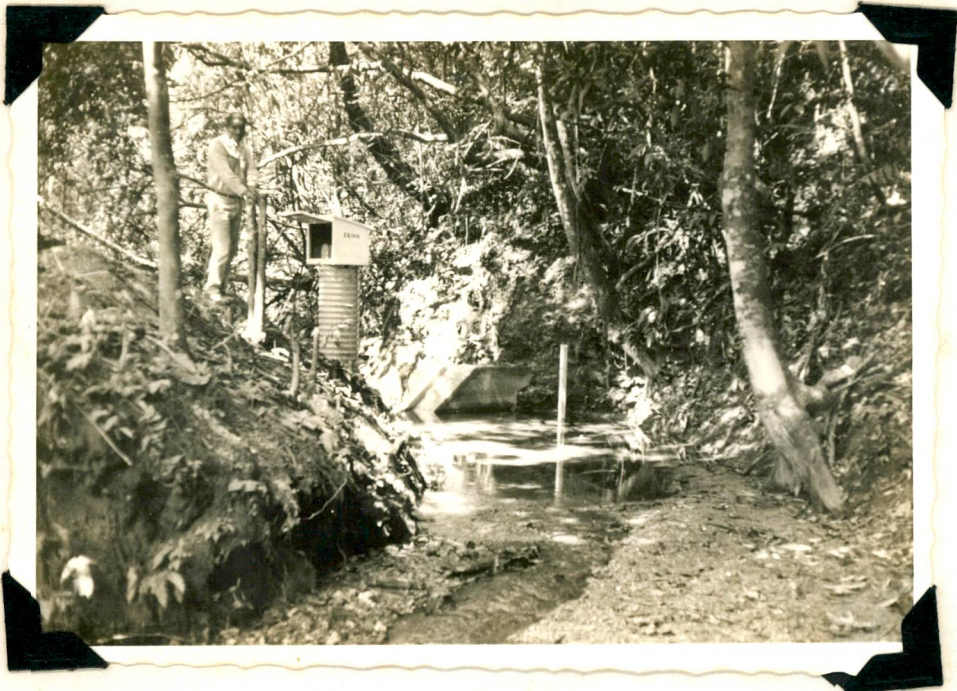
VISTA DEL VERTEDERO DE LA QUEBRADA CAJA DE AGUA
