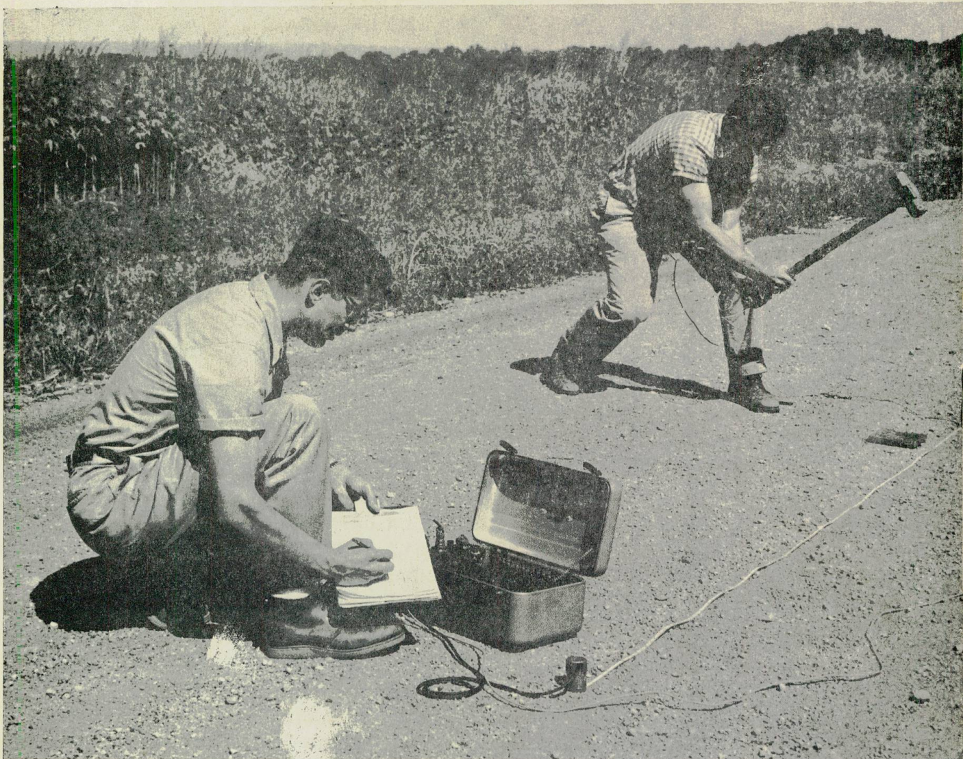
El impacto de un mazo contra una plancha de acero, envía ondas sísmicas al receptor, el cual detiene al contador electrónico. Esta prueba la pueden hacer dos hombres en cuestión de minutos.
