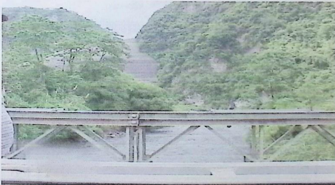
PASO ANGOSTURA VISTA AGUAS ARRIBA
