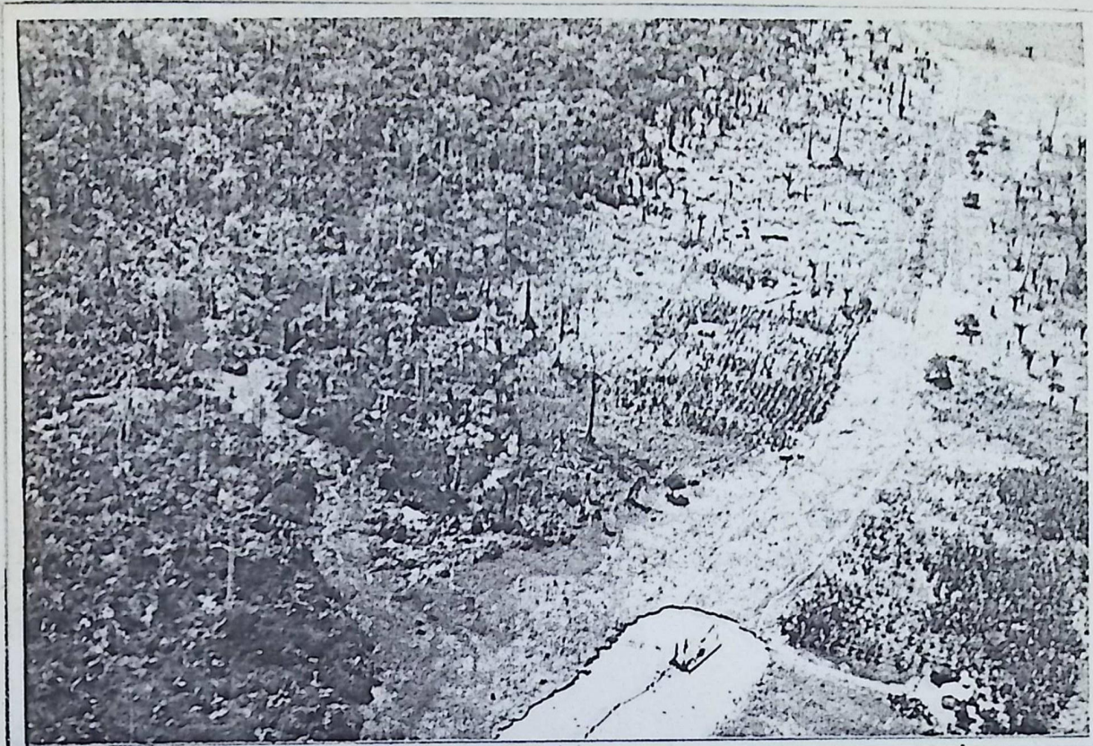
24. Dragado del canal Guachi-Capazón
