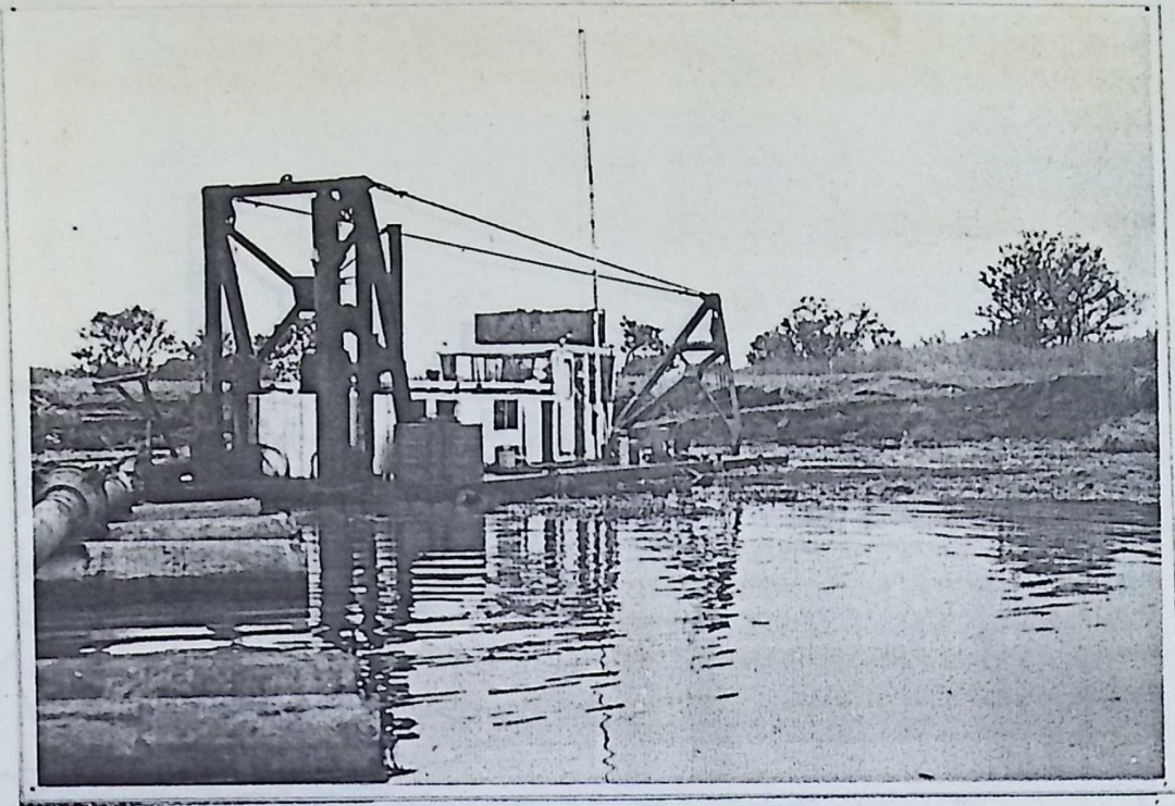
30. Vista de una draga en su proceso de excavación canal Río Guamo.
