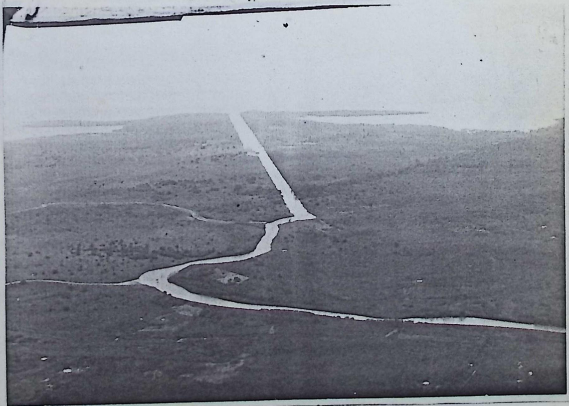
27. Canalización descarga Río Chama al Lago.
