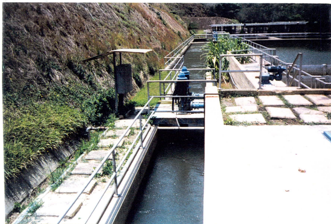
CANAL DE TRANSPORTE A FILTROS SALA "B".-
