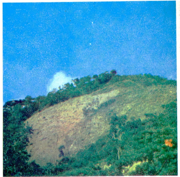
III-2 Zona sin vegetación y con pendiente pronunciada. La deforestación efectuada por los conuqueros, aumenta la escorrentía y suministra material de arrastre. La falta de cobertura vegetal propicia la erosión.
