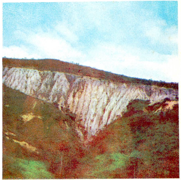
VI-2 Bote incontrolado de material aguas arriba de una alcantarilla. Se ha debido exigir una reforestación y una compactación rudimentaria, pues los arrastres perjudican el funcionamiento de la alcantarilla.
