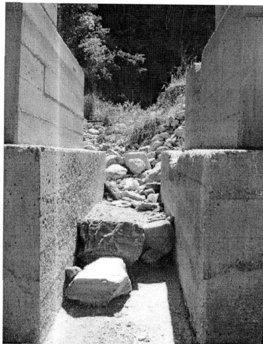
Figura 12. Vista frontal de la ranura #8 en la Presa #2 de la Quebrada El Cojo, mostrando la obstrucción para el año 2005 y para el año 2007.
