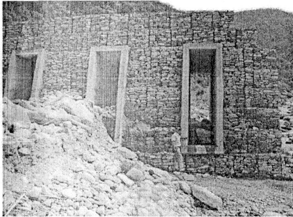
Figura 8. Vista desde aguas arriba de la acumulación de sedimentos en las ventanas de la Quebrada Camuri Chico.
