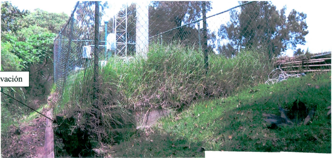
Foto 1. Socavación de la parte de atrás de la estación Humboldt
