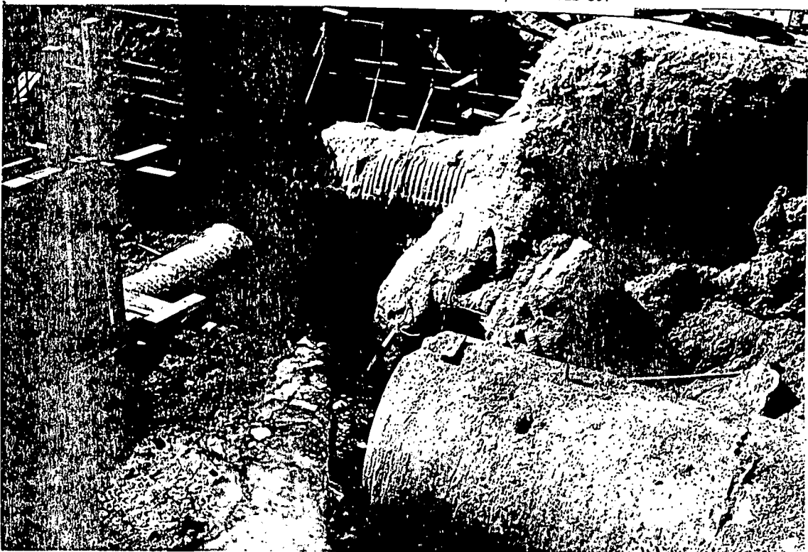
28. Vista de tuberías existentes en Tanquilla TLL-13.
