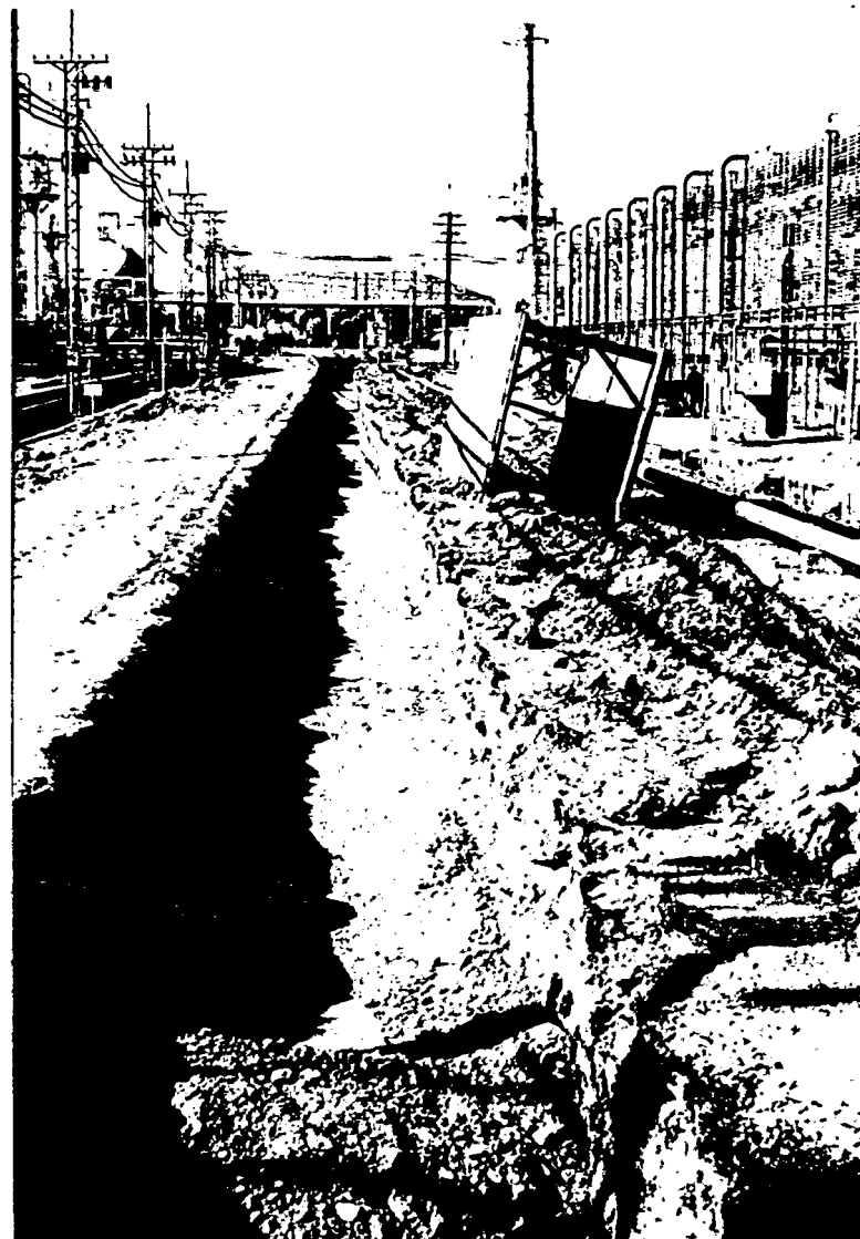
4. Zanja parcialmente rellena en calle 34 del trazo 6.
