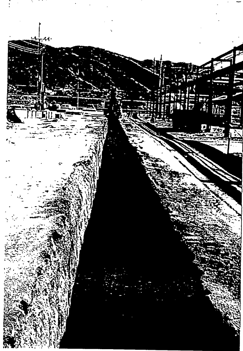
26. Excavación y relleno del trazo 8.
