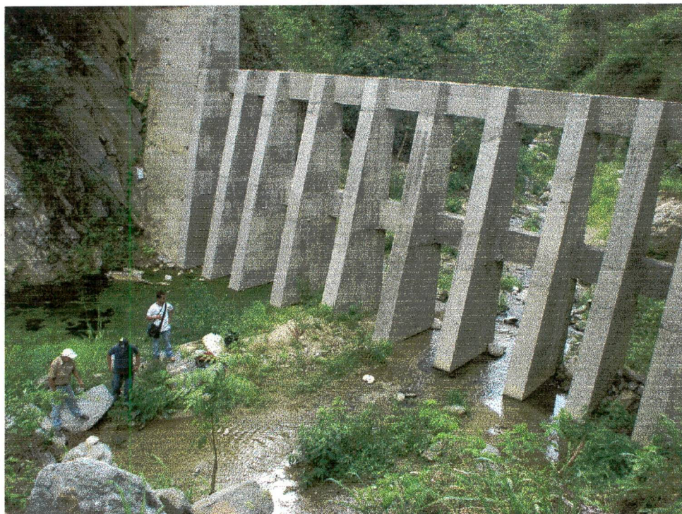
San José de Galipán- Presa nº 1 (vista hacia aguas abajo)
