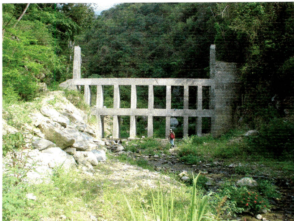
San José de Galipán- Presa n° 1 (vista hacia aguas arriba)
