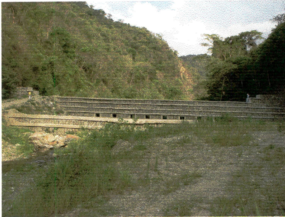
Quebrada Migueleno – Presa n° 1
