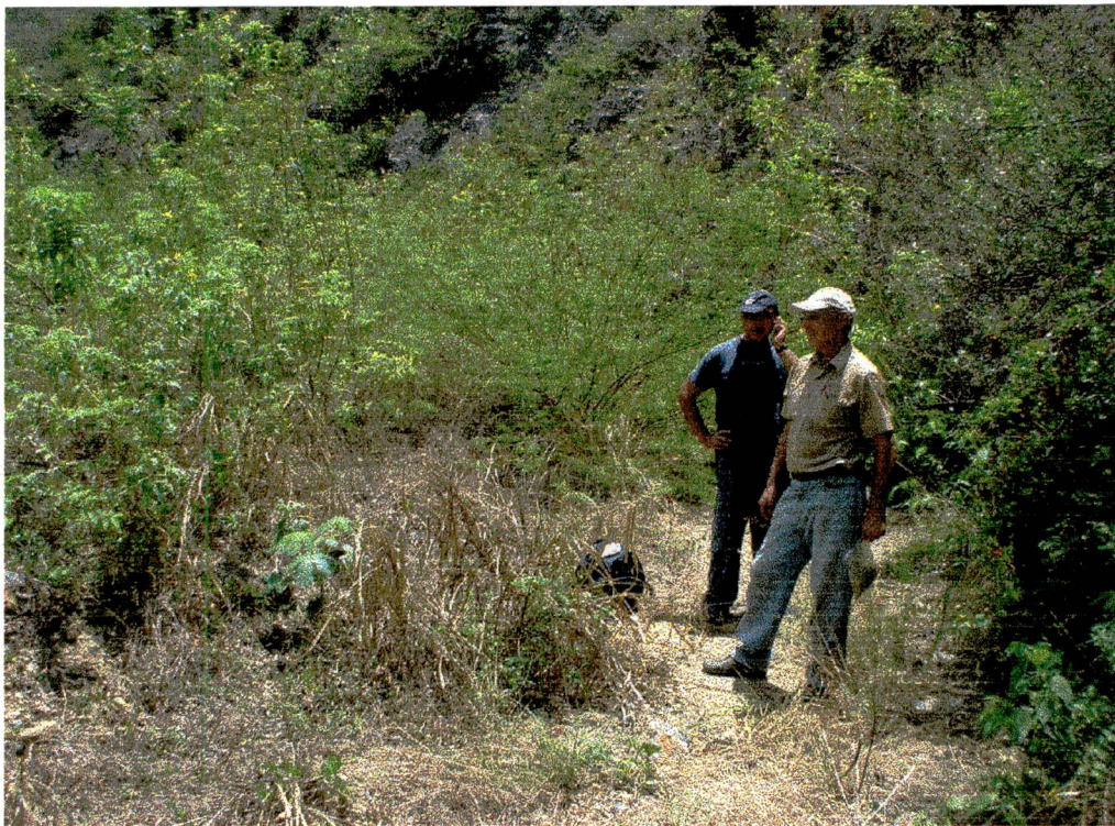
Alcantarilla- vaso sedimentado de la presa n° 1
