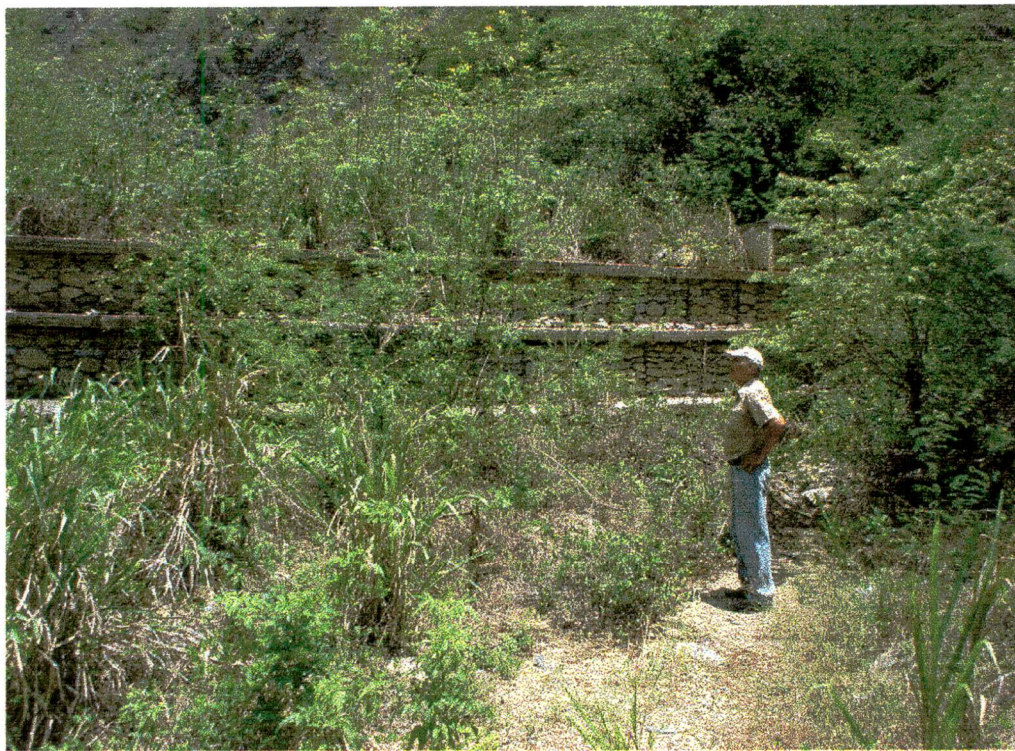
Alcantarilla. Presa n° 2
