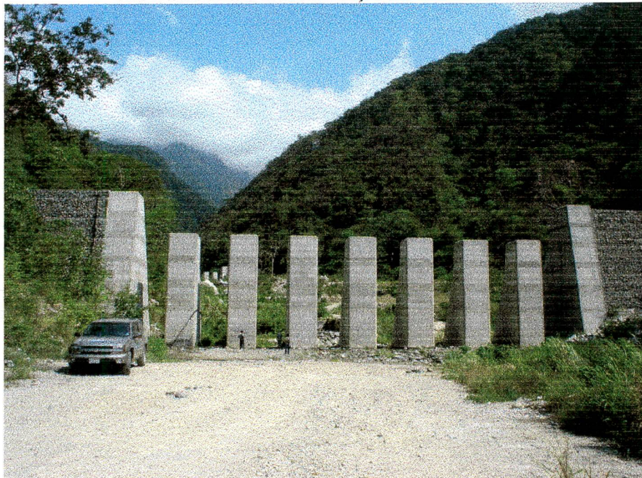
Rio San Julián- Presa nº 2, vista desde abajo
