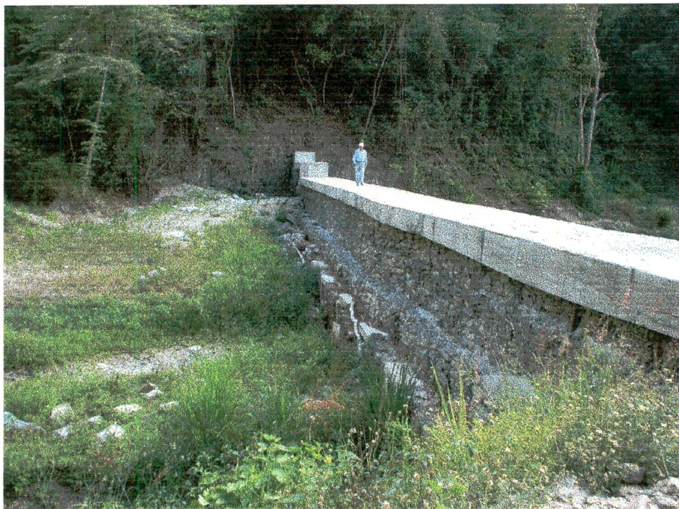
Quebrada Migueleno- Presa n° 1 - Vista desde aguas arriba
