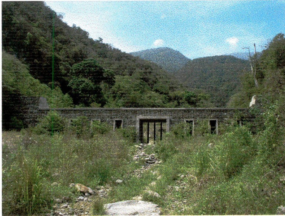
Quebrada Camurí Chico- Presa vista desde aguas abajo
