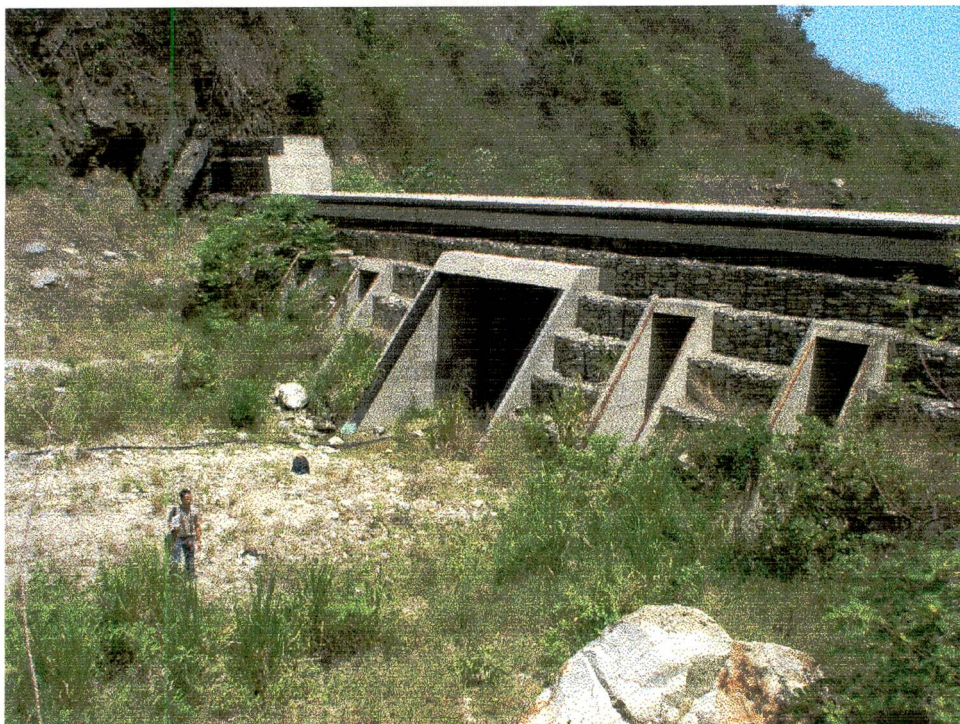
Quebrada Camurí Chico- Presa vista desde aguas arriba
