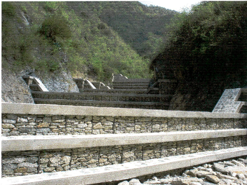
Alcantarilla- Conjunto de presas nº 3. (presa principal al fondo y 4 presas auxiliares)
