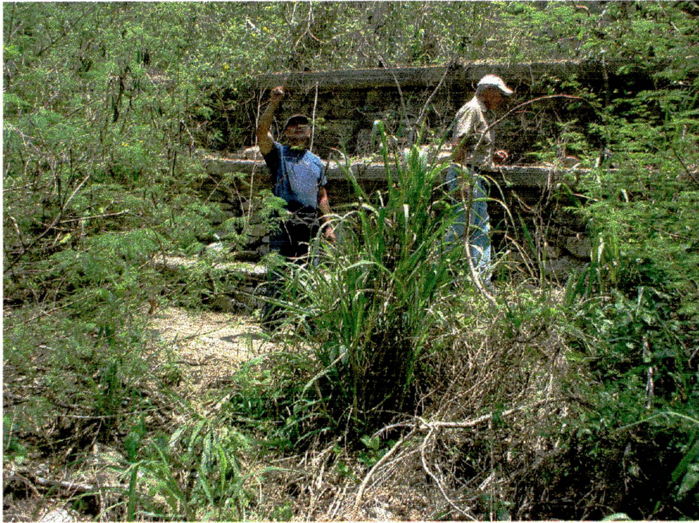
Alcantarilla- Presa n° 1 (vista desde aguas abajo)
