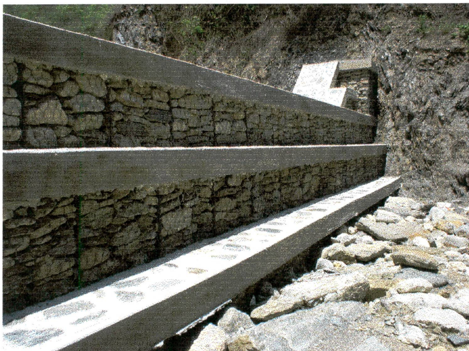
Alcantarilla- Presa nº 3 (principal)
