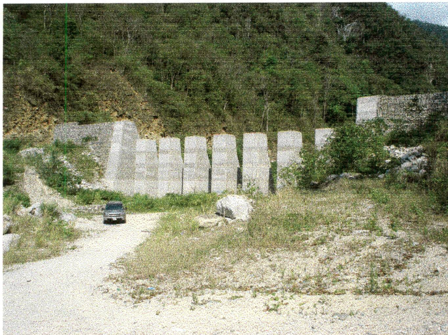
Rio San Julián- Presa n° 1, vista desde abajo
