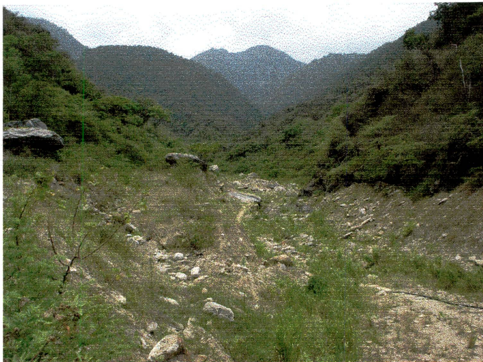
Quebrada Camurí Chico- Vista hacia aguas arriba de la presa
