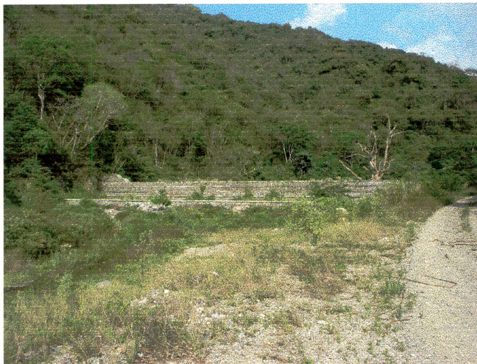
Quebrada Migueleno- Presa n° 2 (vista hacia aguas arriba)
