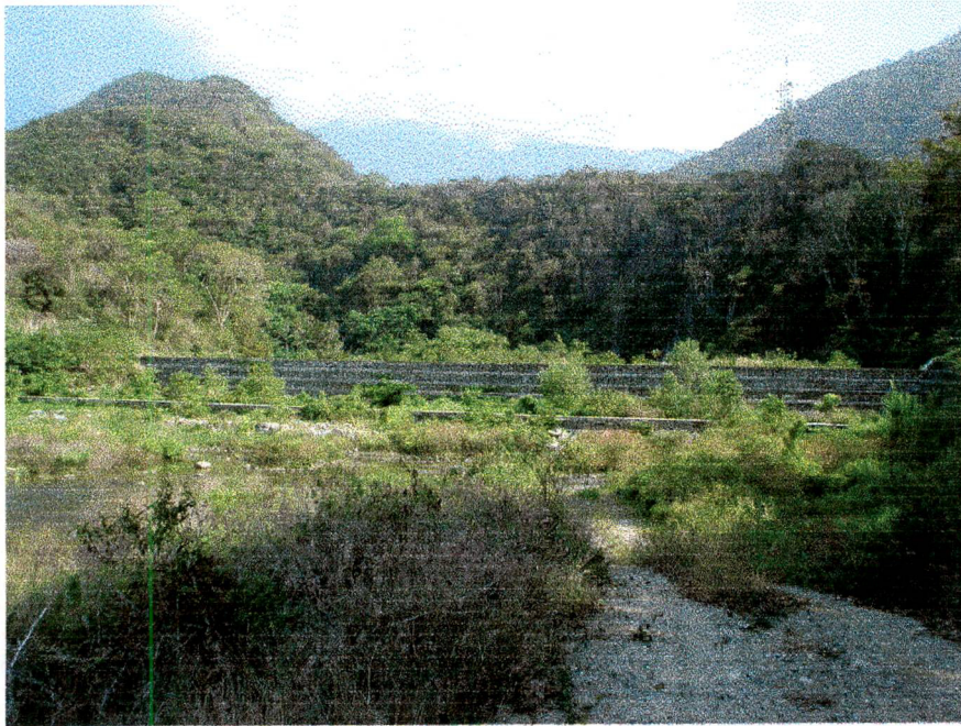
Quebrada Migueleno- Presa n° 3
