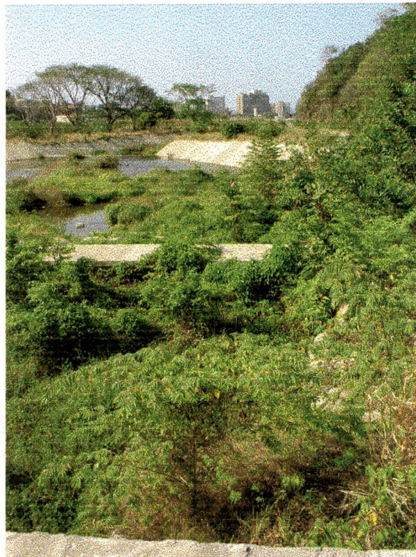
Quebrada Migueleno – Vista desde la Presa n° 3 hacia el canal
