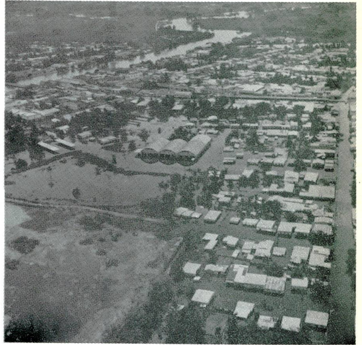
Detalle del área urbana inundada. Vista al N.
