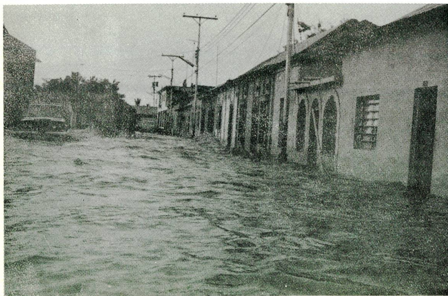
Calle La Gloria. Las viviendas fueron abandonadas.
