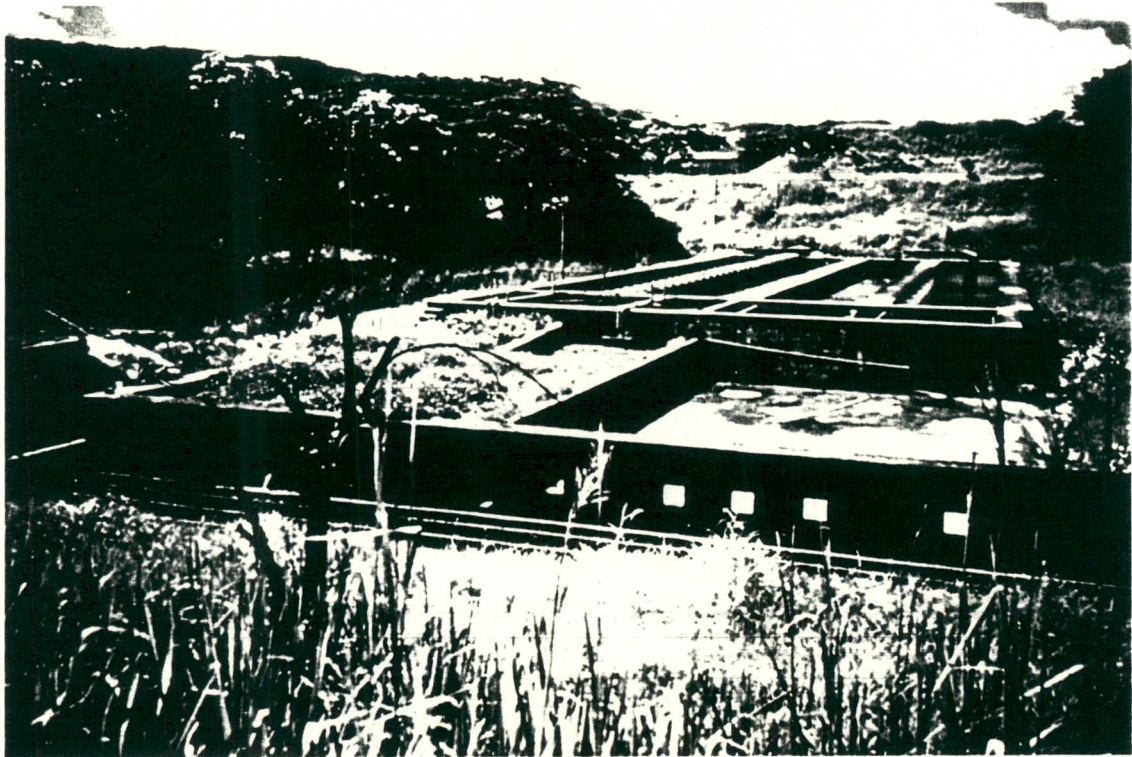
N° 9. Planta de Tratamiento de Urb. Ind. Río Tuy en Charallave
